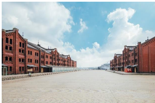
<横浜赤レンガ倉庫 外観>
