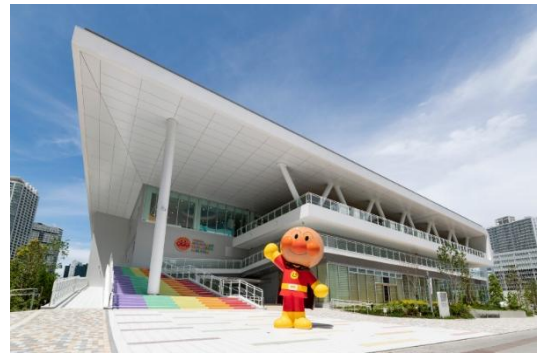
▲現在の「横浜アンパンマンこどもミュージアム」外観
